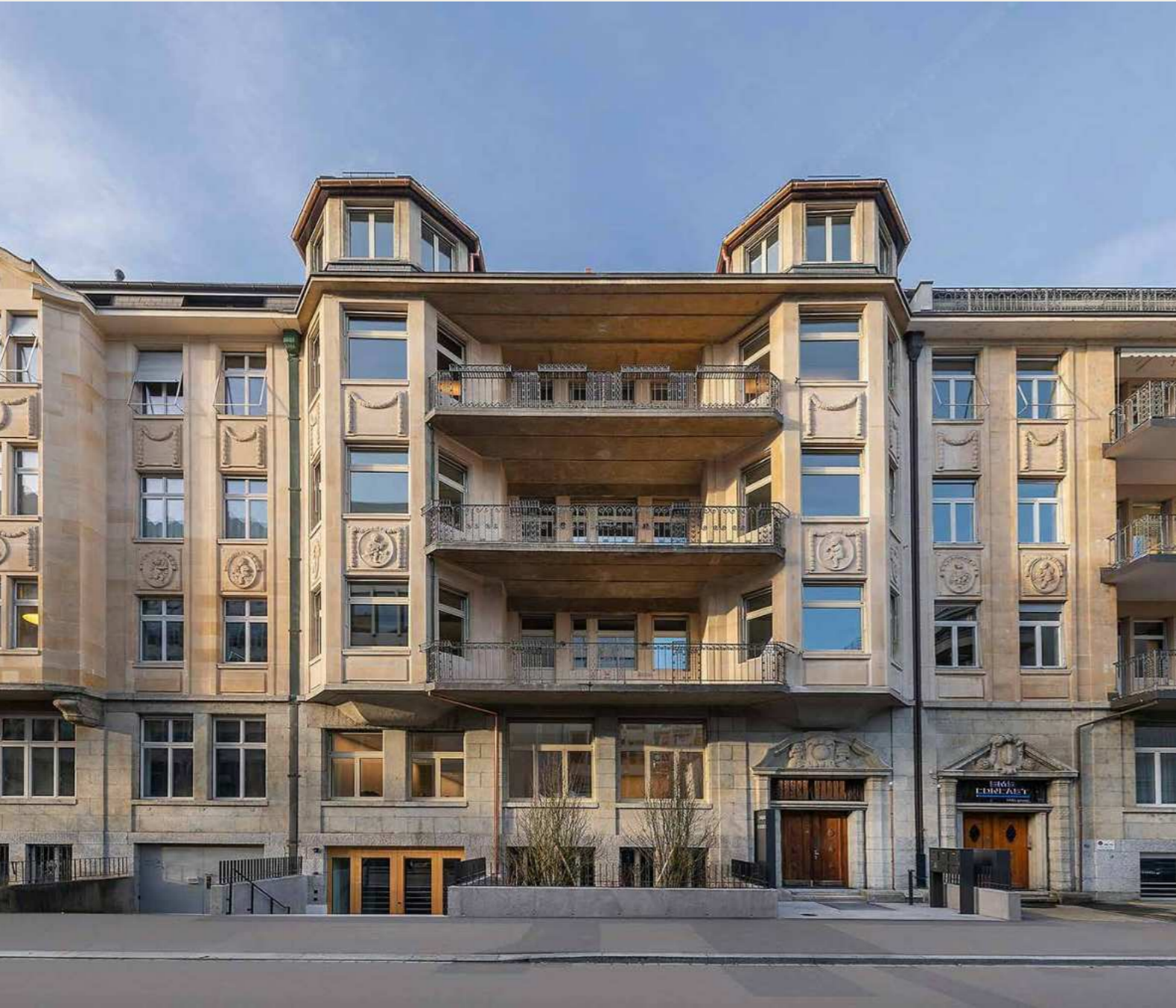
Aussenansicht der Liegenschaft Tödistrasse 7, nach der Sanierung
